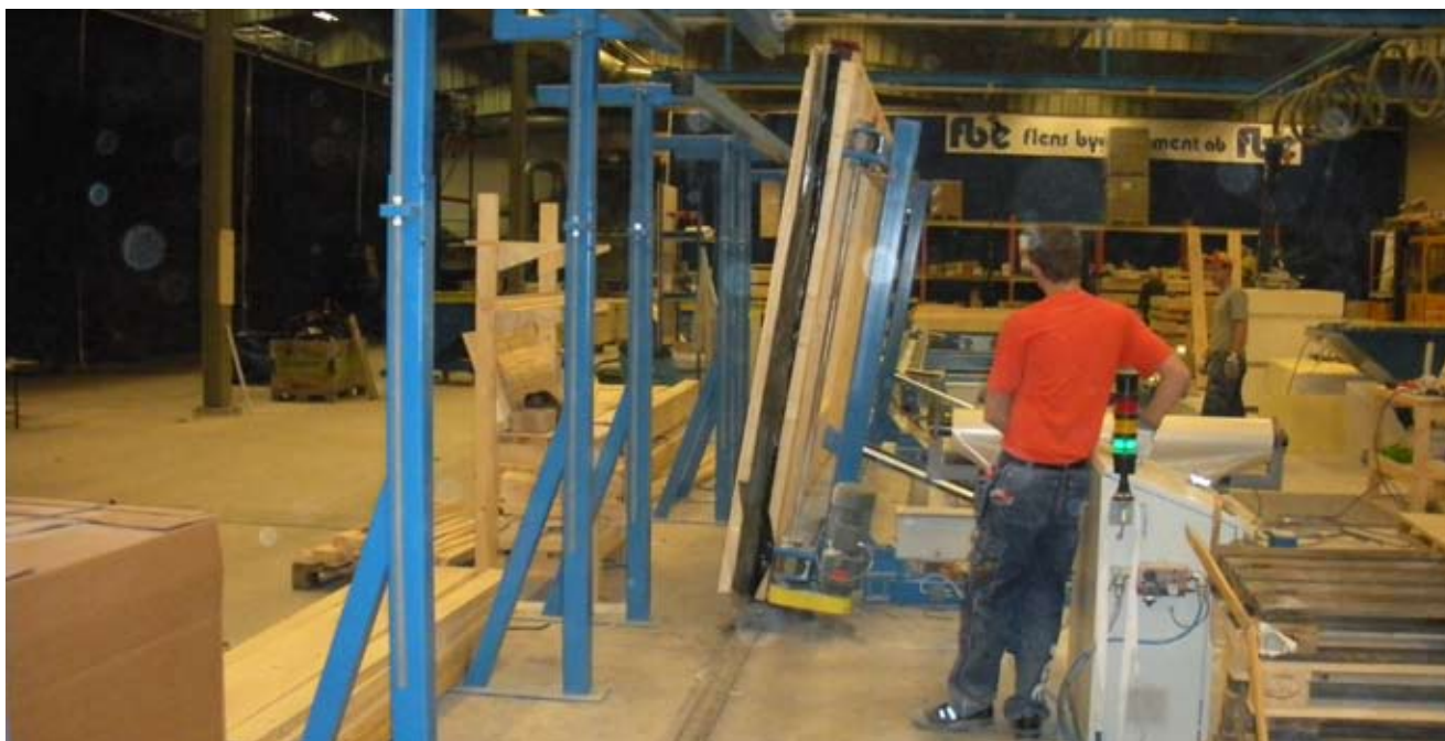
Element ścienny zostaje ustawiony w pionie i podany do wyjściowego przenośnika elementów w pozycji pionowej bezpośrednio z linii Combi w celu wydajnego montażu okien, itp.
